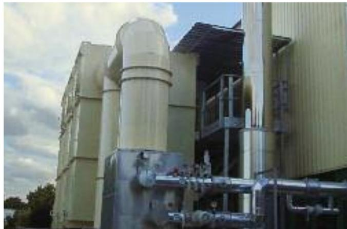
Abb. 3: Rückansicht der RNV. Im Vordergrund Wärmerückgewinnung und Kamin.
